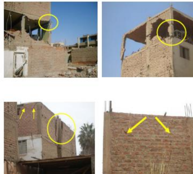
Figura 11. Daños en edificios de albañilería reforzada
